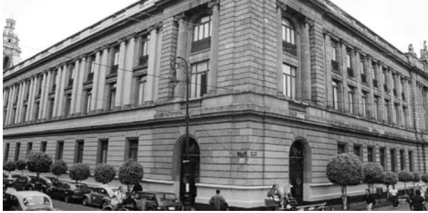
Actual sede de la SEP, antes Antigua Iglesia de la Encarnación.
